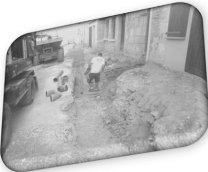
*Mise en place du collecteur d'eau pluviale et raccordements aux regards en pied de chute.*
