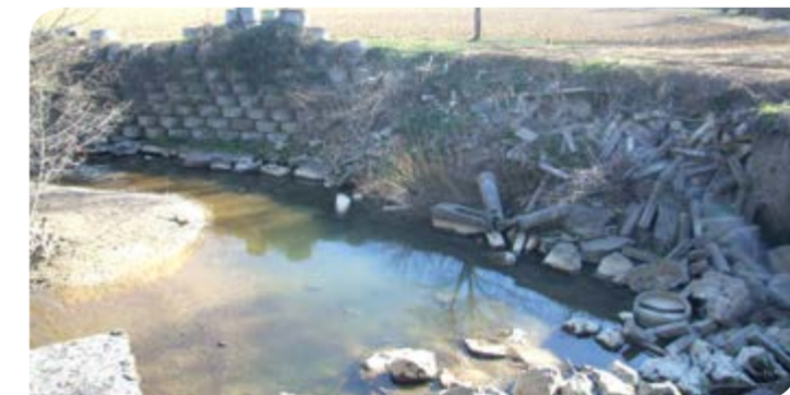
Protection de berges
